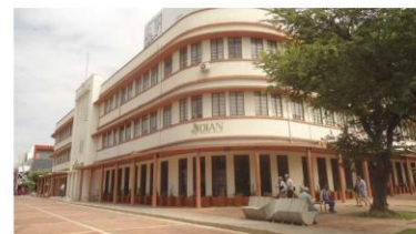
Edificio Santander y Plazuela del Libertador
