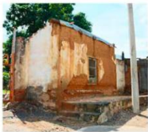
Estación San Luis
