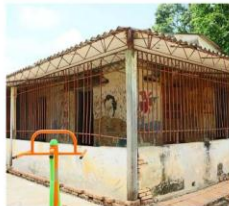
Estación Puerto Villamizar
